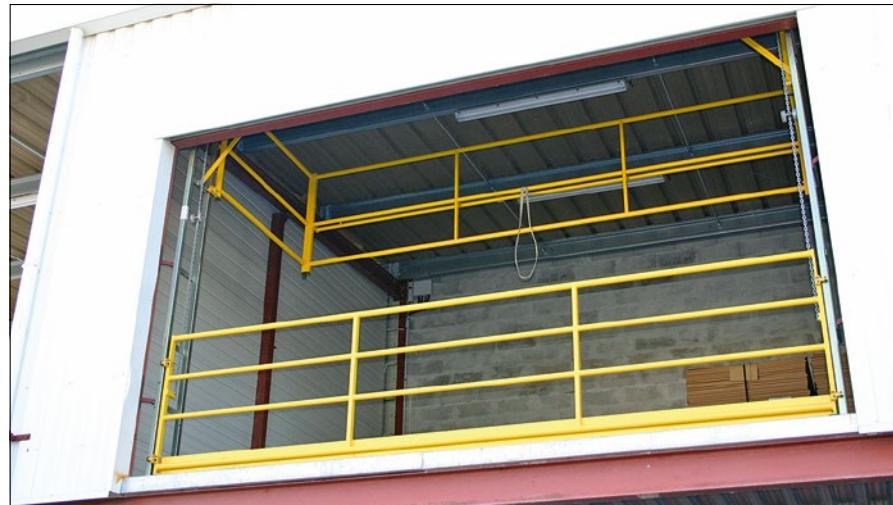
**Typ C2: Bautiefe 1800mm montiert an einer Gebäudeöffnung. Ansicht von Außen.**
