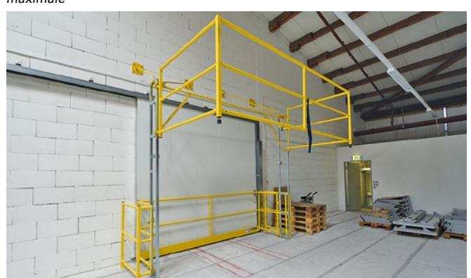
**Abgesicherte Absturzkante, Schiebetor geschlossen. Schiebetor könnte jetzt von Hand geöffnet werden.**
