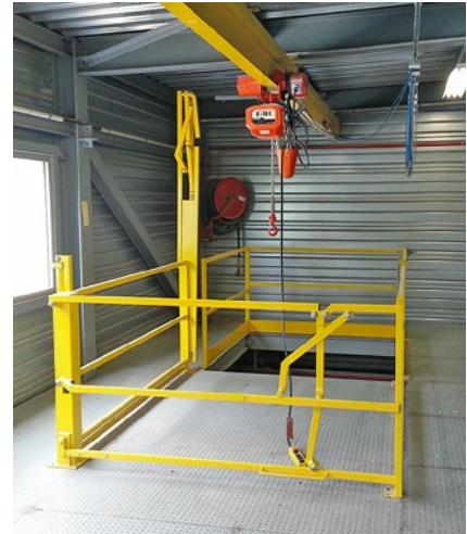
**Typ L2G-BCR:** Getriebe links öffnend, komplett zusammenfaltend. Anwendung bei sehr geringen Raumhöhen und mit Kranbedienung.
