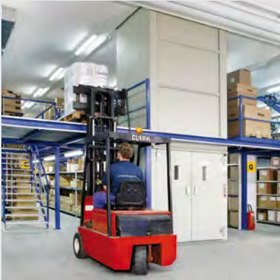
Über Aufzuganlagen gelangen Personal und Ware problemlos in die oberen Ebenen.
