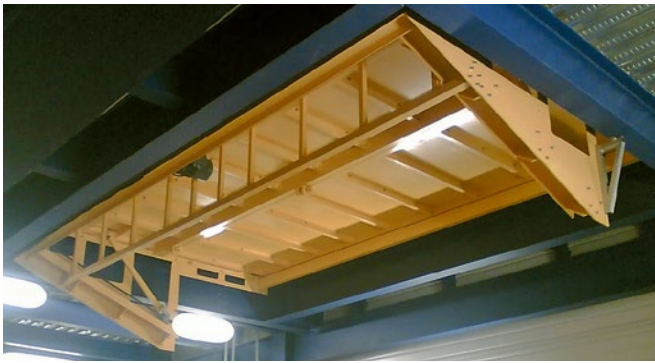
Ansicht von unten, geschlossene Bodenluke. Vue de dessous, trappe de plancher fermée.
