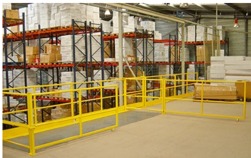
Schleuse mit 2-flügeligen Toren. Abb.: 1 Flügel offen Schiebetor geschlossen, Bühnenkante gesichert. Sas avec portes à 2 battants. III. : Porte coulissante à 1 battant fermée, bord de la plate-forme sécurisé.
