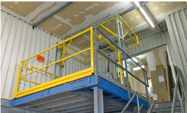
Ansicht von unten, Absturzkante gesichert, Schleusenraum von hinten befüllbar.
