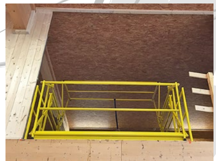
Typ BND, Ansicht von unten, Absturzkante gesichert.
