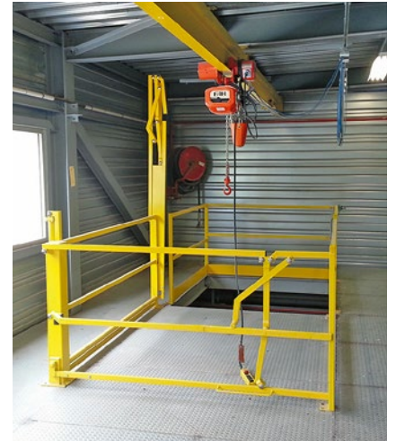
Typ L2G-BCR: Getriebe links öffnend, komplett zusammenfaltend. Anwendung bei sehr geringen Raumhöhen und mit Kranbedienung.
