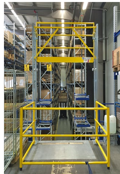
C1, Bühne gesichert, Absturzkante offen.
