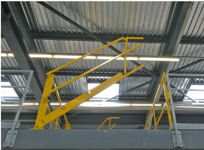
Typ L2D: die beiden Schleusenseiten funktionieren mit Getriebe synchron zueinander.
