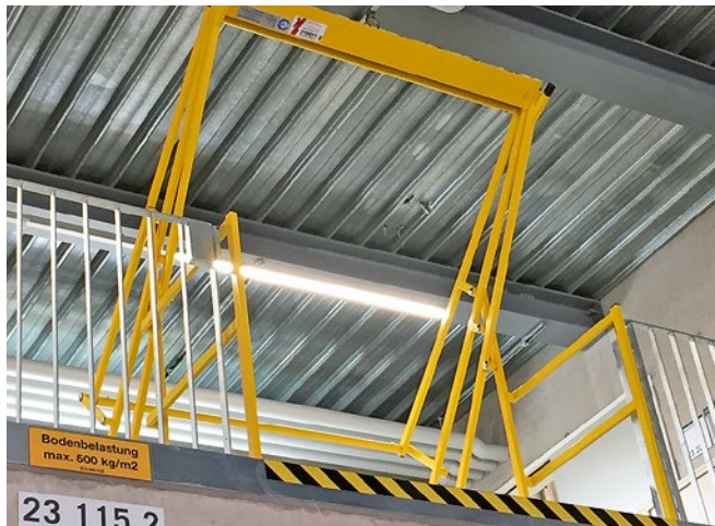
Ansicht von unten, Absturzkante mit Markierung Vue de dessous, bord de la zone présentant un risque de chutes sécurisé
