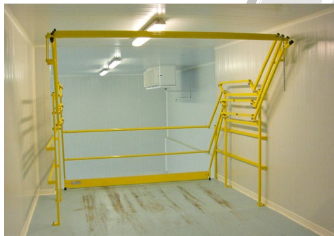
Typ T2L-SO: Palettenhöhe 2000 und Nutztiefe 2600mm. Anwendung im Kühlraum. Absturzkannte gesichert.
