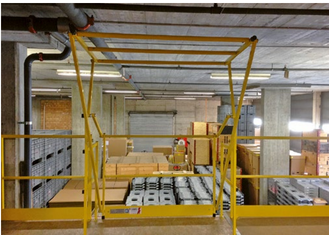
Typ B Schleuse und Handlauf kombiniert Sas version type B et garde-corps combinés
