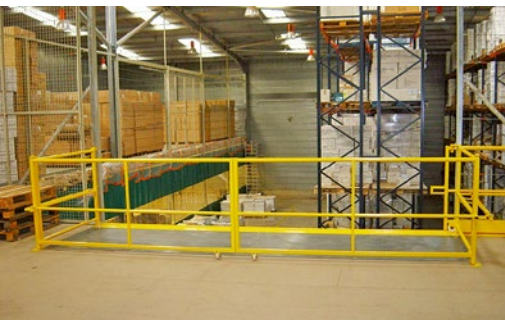
Schleuse zur Bühne geschlossen (gesichert). Schiebetor offen Sas de la plate-forme fermé (sécurisé). Porte coulissante ouverte
