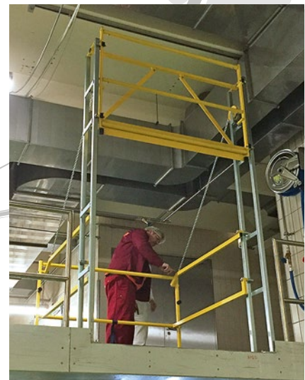
Bühnenkante gesichert, Klappgeländer offen Bord de la plate-forme sécurisé, garde-corps rabattable ouvert
