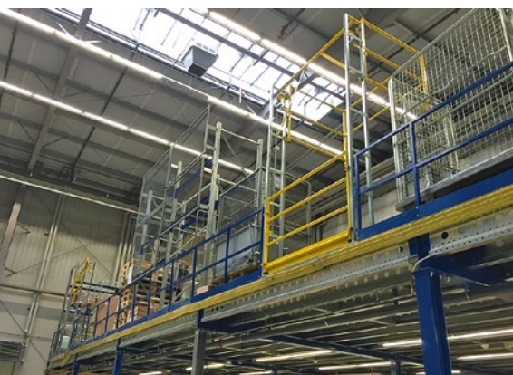
C1, Ansicht von unten, Absturzkante gesichert.
