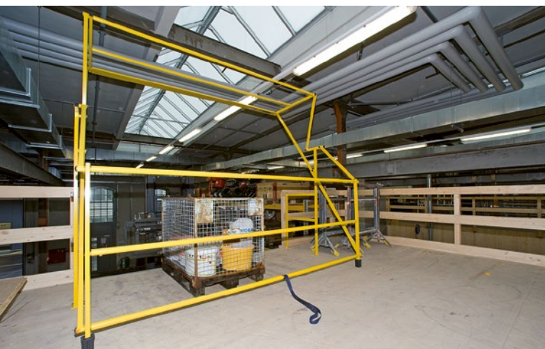
Schleuse offen für Warenentnahme mit Stapler
