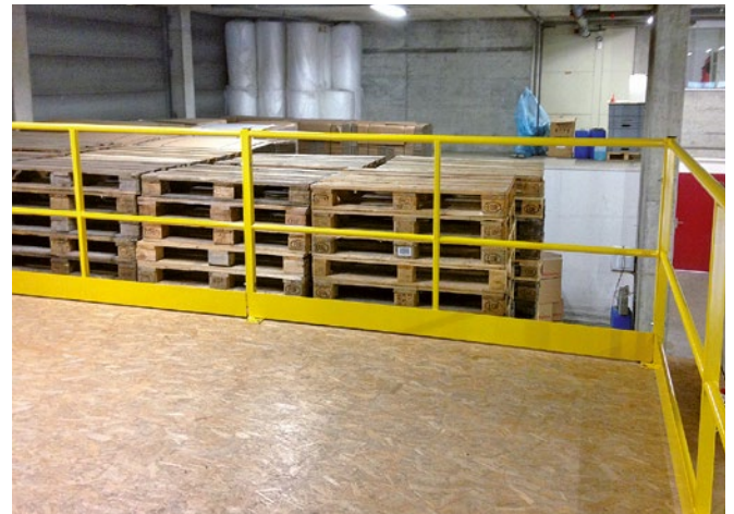
Handlauf – mit Handlaufprofil, Knieleiste und Fussleiste nach DIN EN Normen und SUVA Norm.
