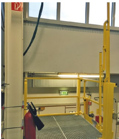
Typ LA1D: gesicherte Absturzkante, Bühne freier Zugang.
