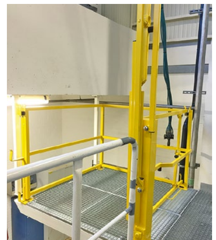
Typ LA1G: Absturzkante offen, Bühnenseite gesichert.
