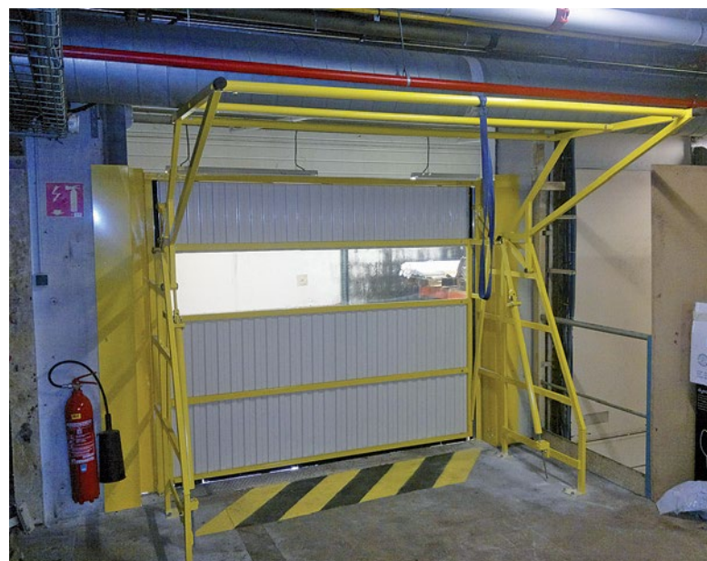
▲ Bühnenkante geschlossen, Schwenkflügel mit Trapezblech und Sichtband verkleidet
