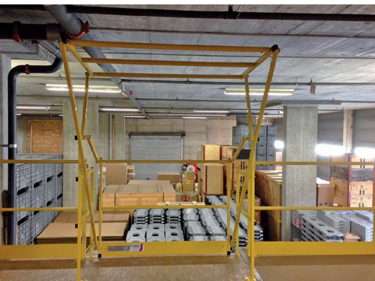
▲ ▼ RB-Schleuse und Handlauf kombiniert
