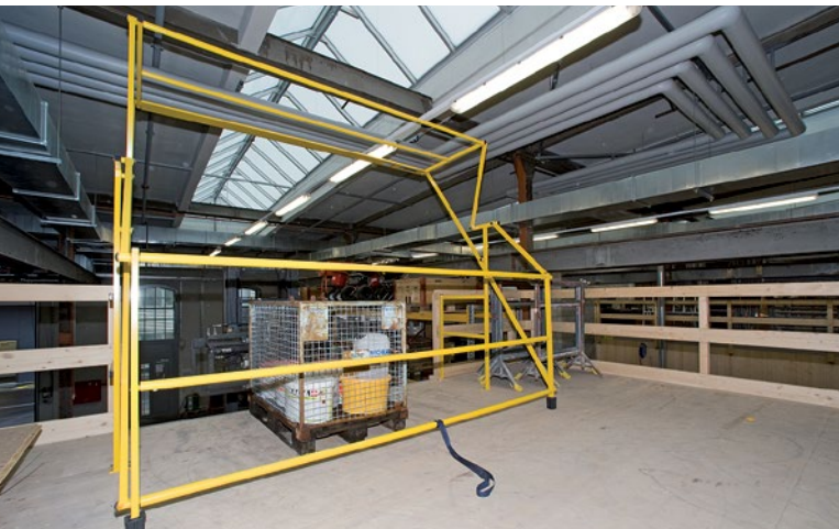
Schleuse offen für Warenentnahme mit Stapler ▲ ▼
