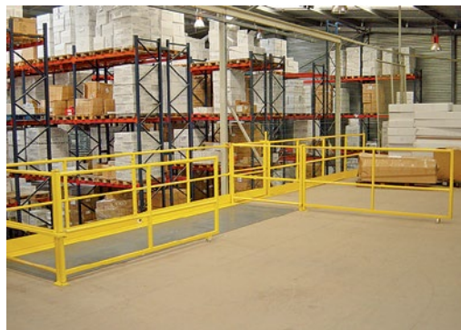
▲ Schleuse mit 2-flügeligen Türen. Abb.: 1 Flügel offen Schiebetor geschlossen, Bühnenkante gesichert.
