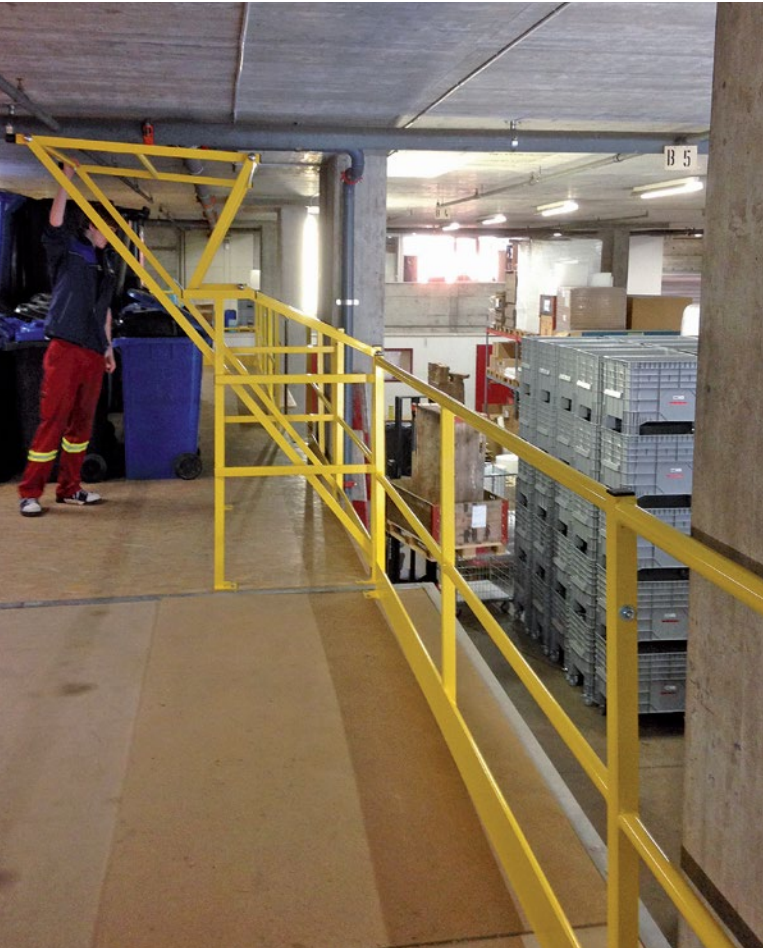
▲ ▼ RB-Schleuse und Handlauf kombiniert
