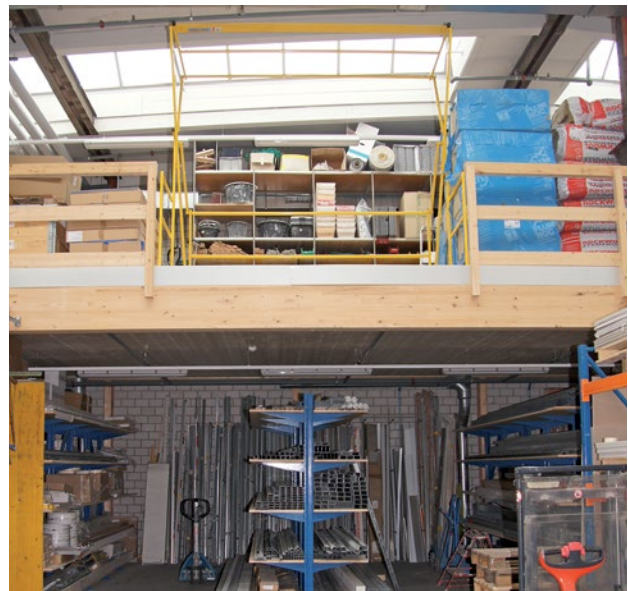
▲ Schleuse offen, frei für Beladung oder Entnahme mit Stapler.
