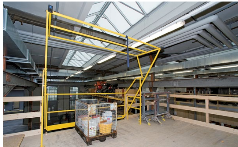
▲ Geöffnetes Schleusengeländer – Bühnenkante gesichert
