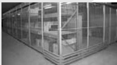
Gittertrennwände und Fallschutzgitter im Hochregalbereich
