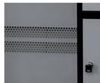
Lüftungsschlitze in der Rückwand sorgen für permanente Frischluftzufuhr.
