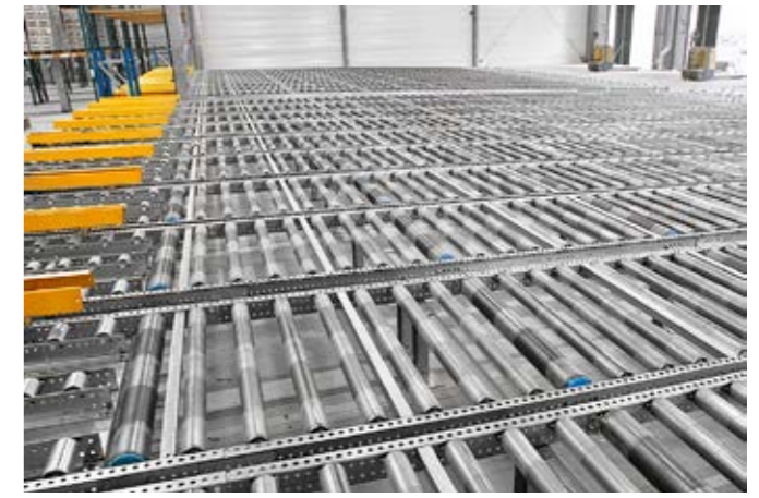
Durchgehende Rollenbahnen zur Versandbereitstellung
